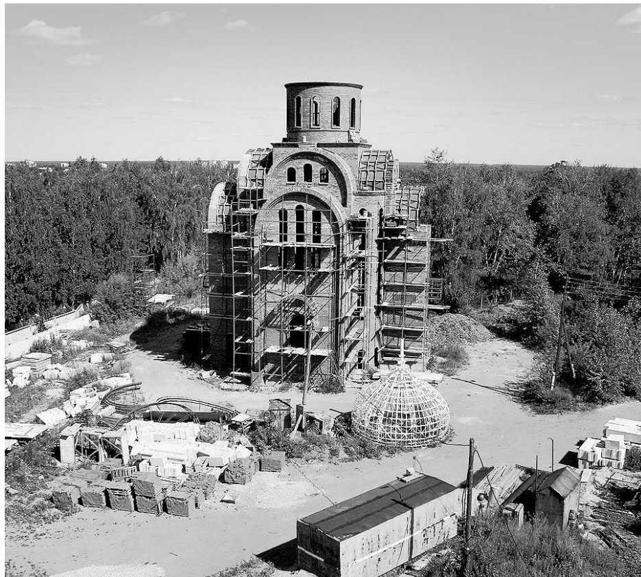
2007 год, огромный купол собирают тут же, на месте строительства.
